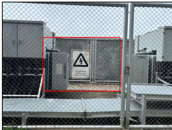
เสาไฟฟ้าและหม้อแปลงไฟฟ้า ที่ห่างจากอาคารข้างเคียง พร้อมติดป้ายเตือน “อันตรายไฟฟ้าแรงสูง”
