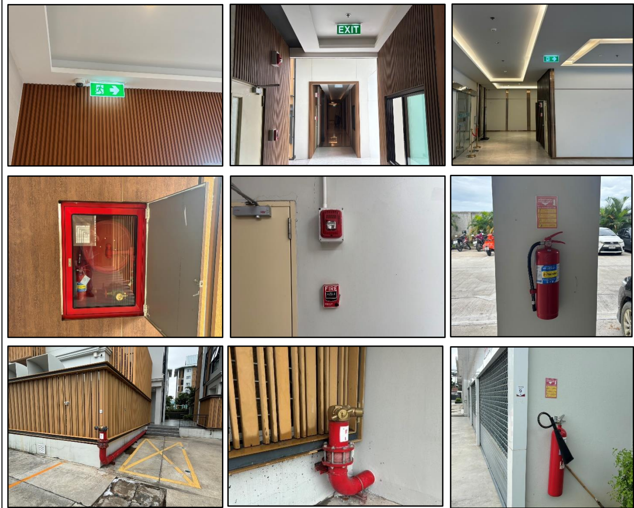
อุปกรณ์ป้องกันอัคคีภัยต่างๆ ทางบอกหนีไฟ และตู้หัวฉีดน้ำดับเพลิง (FHC)
